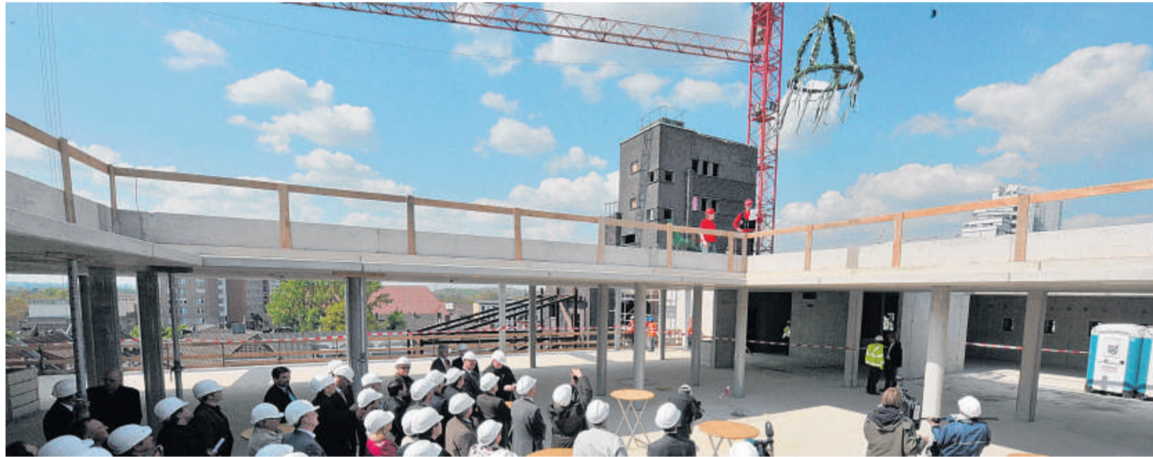
Der Richtkranz hängt über dem (künftigen) Patio und der fünften Etage. Geladene Gäste verfolgten den Richtspruch von Polier Martin Kramer.
